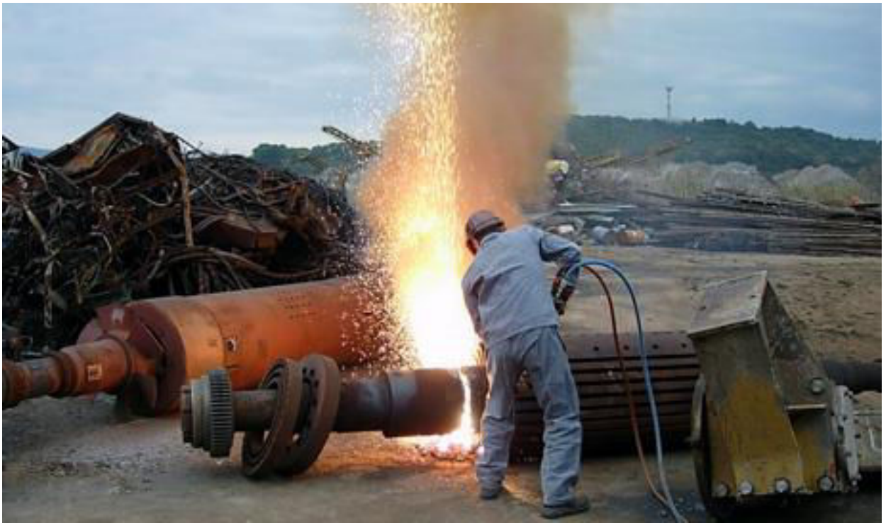
5.7. Pav. Stambių metalo laužo konstrukcijų smulkinimas pjaustant dujomis
